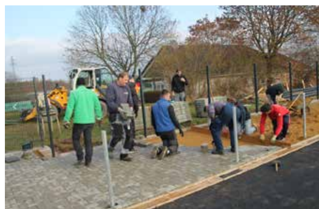
Sportplatzsanierung und Bau Gerätehaus 2016
